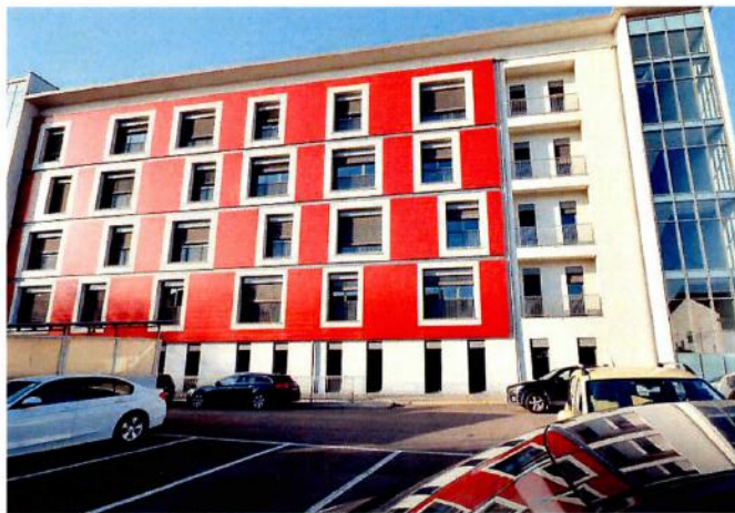
I nuovi padiglioni ospedalieri a Voghera: il Pronto soccorso verrà realizzato al piano terra
