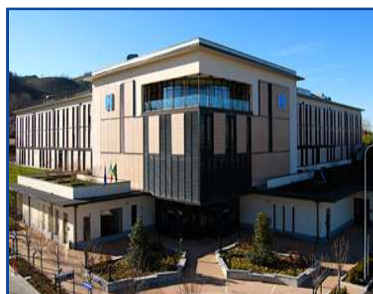
Figura 3: Ospedale Unificato di Broni-Stradella
